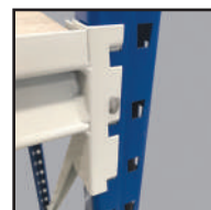
Fixation des longerons et goupille de renfort
