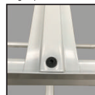
Fixation de la traverse de renfort
